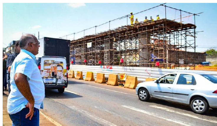
Rogério Cruz verificou andamento da obra do Complexo Viário da Avenida Castelo Branco
